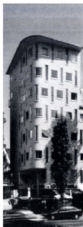
Viviendas en Leopoldstr., 2009 Arq: Otto Steidle
